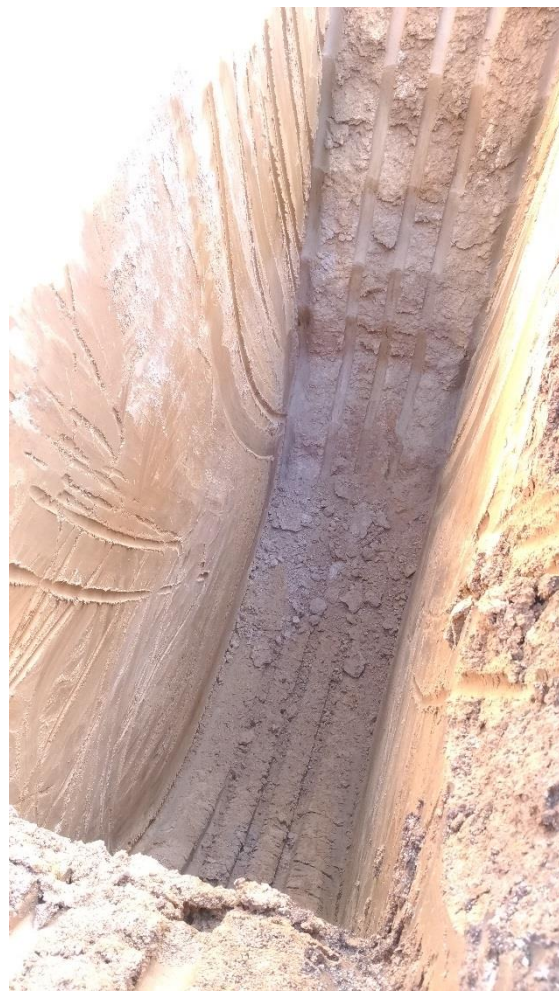
Figura 4 - Trincheira sem desbarrancamentos, uniforme
