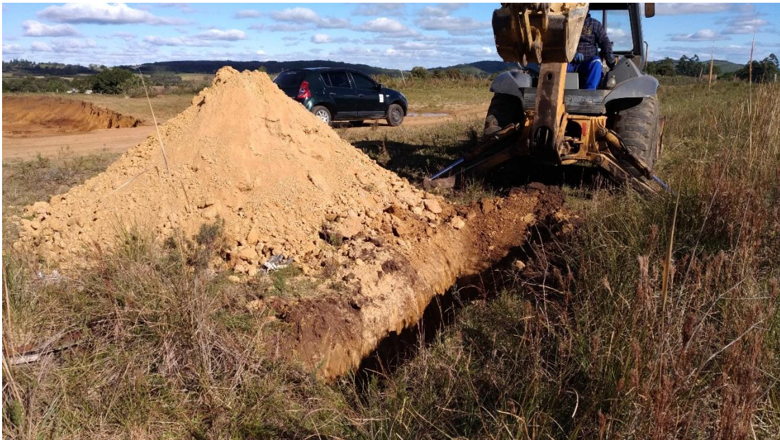
Figura 2 - Trincheira aberta e material retirado ao lado
