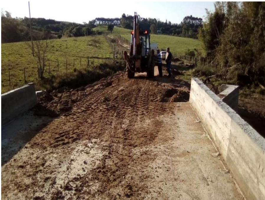
Conclusão dos aterros da Obra, Ponte Rubens Tesmer
