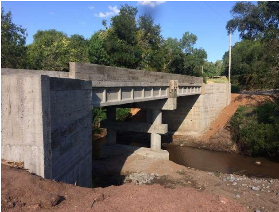
Estrutura finalizada Ponte Coxilha dos Cavalheiros
