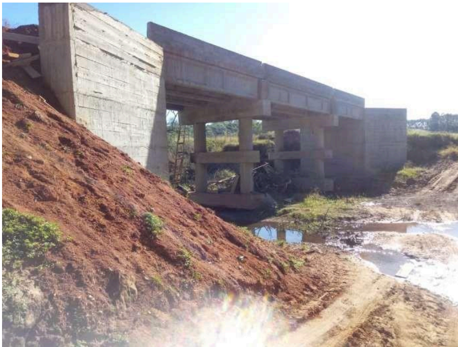
Conclusão da Obra, Ponte Rubens Tesmer
