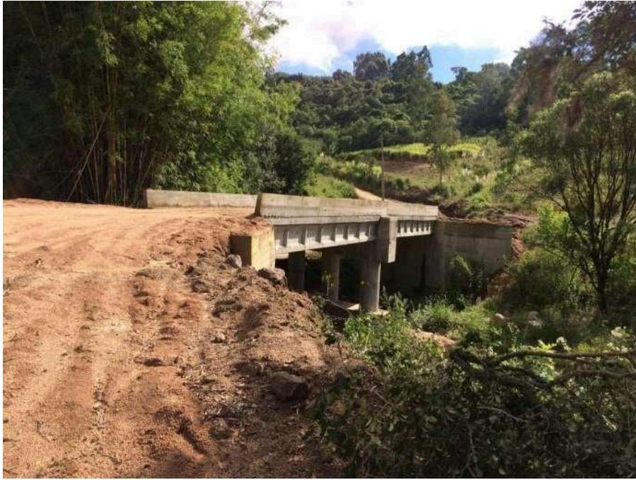
Ponte Santa Barbara concluída
