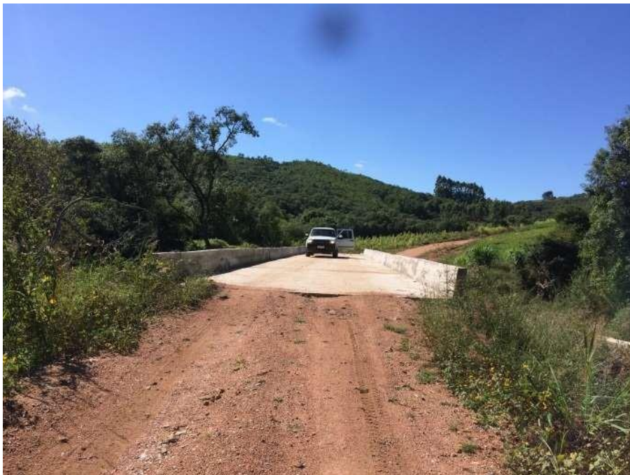
Ponte Florida/Potreiro Grande concluída
