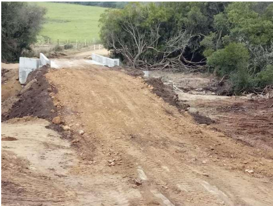
Ponte Passo do Canto concluída
