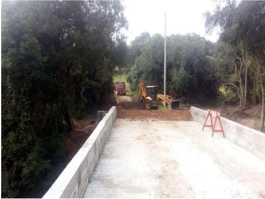
Conclusão da Ponte Coxilha dos Cavalheiros
