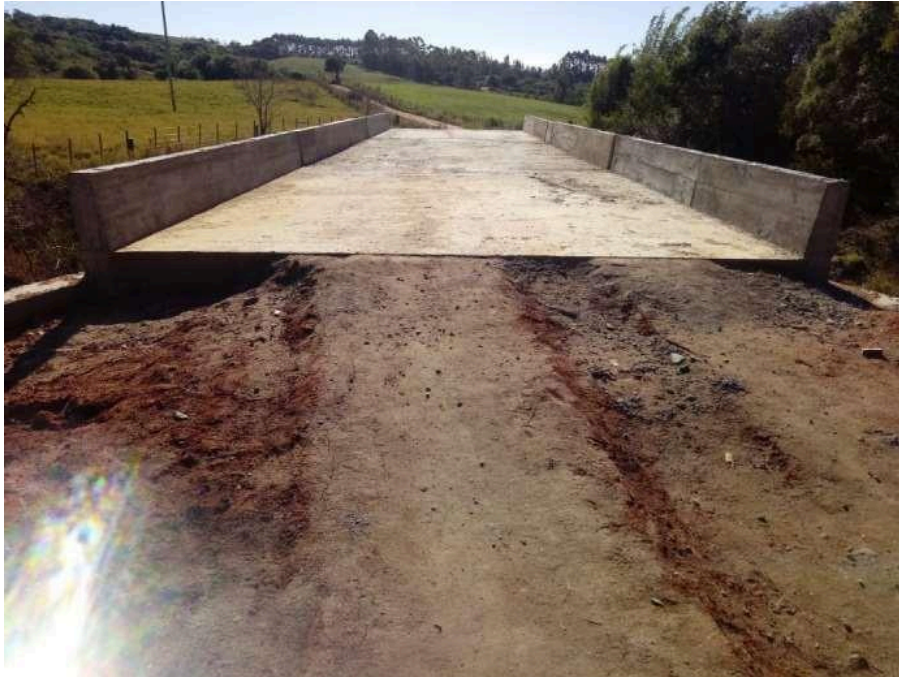
Conclusão da Obra, Ponte Rubens Tesmer
